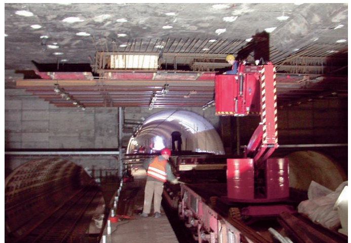
Abb. 8: Das Deckenschalungs-Element in der endgültigen Position
