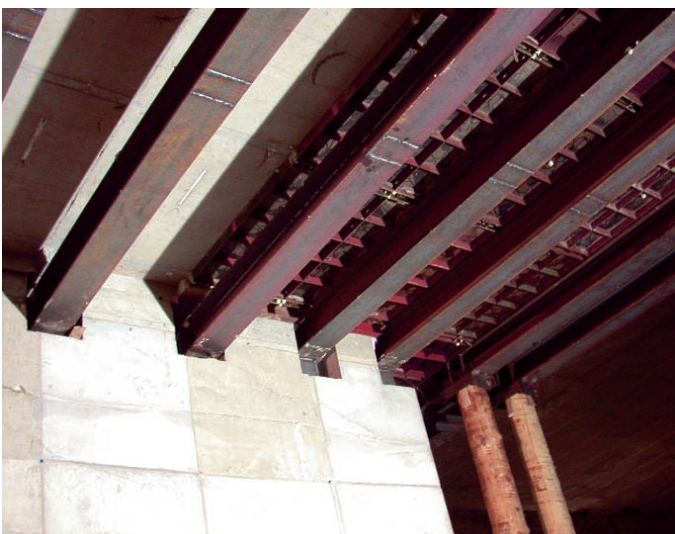
Abb. 14: Teilweise ausgeschaltete Decke mit Unterstützung im auskragenden Bereich
