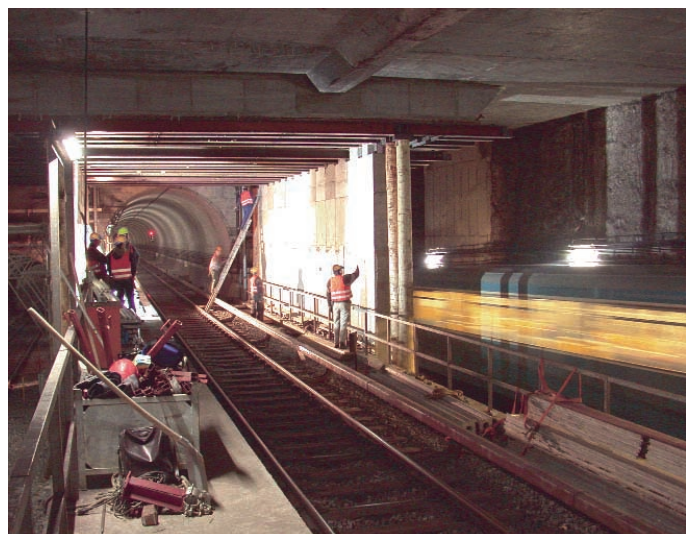
Abb. 15: Die fertiggestellte Unterfangungskonstruktion – Restarbeiten und Räumung der Baustelle
