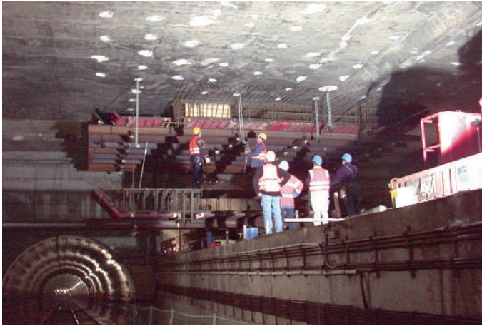
Abb. 7: 4 Kettenzüge zogen das Deckenschalungs-Element nach oben
