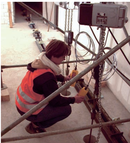
Abb. 7: 4 Kettenzüge zogen das Deckenschalungs-Element nach oben
