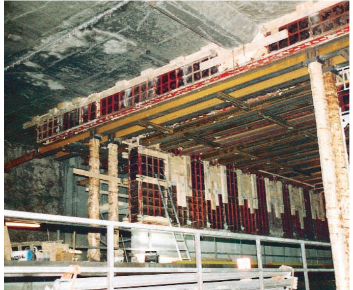
Abb. 13: Eingeschalter Wand-Decken-Anschluss
