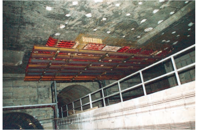
Abb. 8: Das Deckenschalungs-Element in der endgültigen Position
