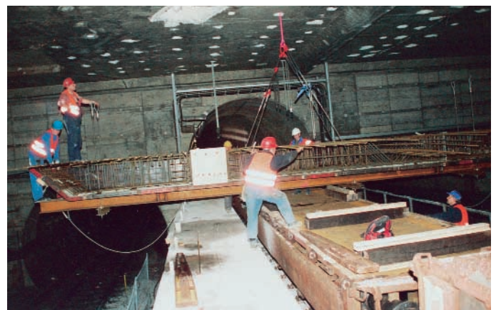
Abb. 6: Die Deckenschalungs-Einheit wurde um 90° gedreht und auf dem Waggon wieder abgesetzt
