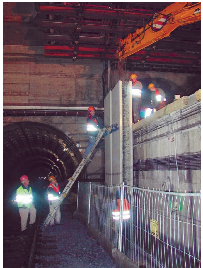
Abb. 11: Aufstellen der Fertigteilwände in beengten Platzverhältnissen
