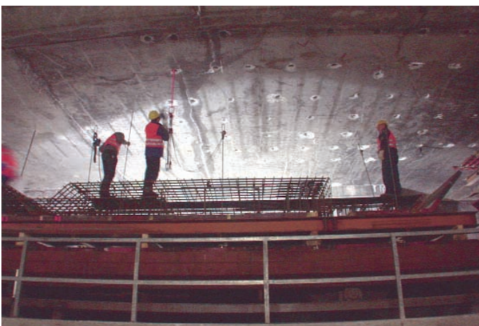
Abb. 5: Deckenschalungs-Einheit mit Ankerstangen
