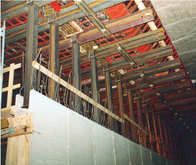
Abb. 12: Stahlträger zwischen Fertigteilwand und Deckenschalungs-Element
