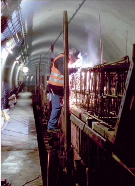
Abb. 3: Wegen der in U-Bahn-Schächten auftretenden Induktionsströme musste die Bewehrung vor dem Einbau verschweisst werden, damit sie später geerdet werden konnte
